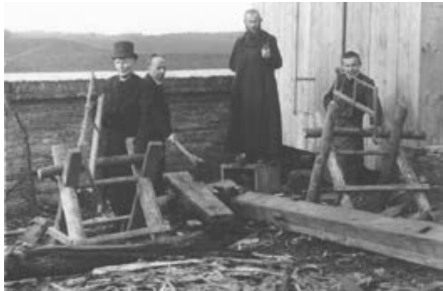
Das Bild zeigt Pfarrer Hauser (2. von li.) 1896 beim Anlegen der Friedhofsterrassen. Die Personen stehen auf der Südseite der 1. oder 2. Terrasse des Friedhofs
