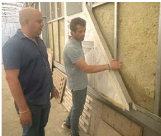
Die ersten Wände für das Kloster auf Kuba entstehen in Ständerbauweise
