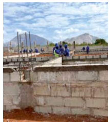
Fundament für das Klostergebäude
