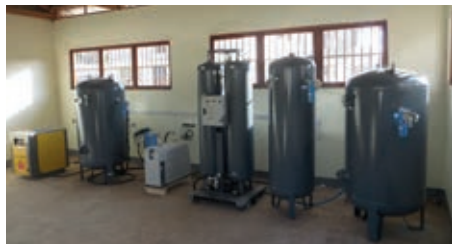
Bild: Sauerstoffproduktionsanlage Ndanda
