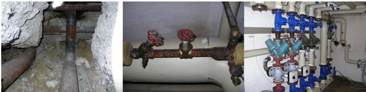
Abbildung 7-1: Beispiele von ungedämmten Rohrleitungen und Armaturen
