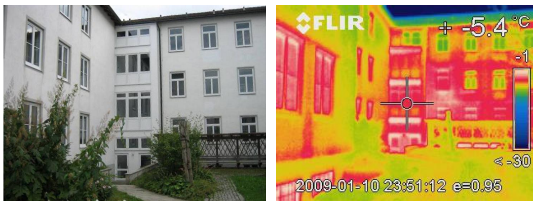
Abbildung 3-4: Nordfassade Gymnasium, Treppenhaus [4]
