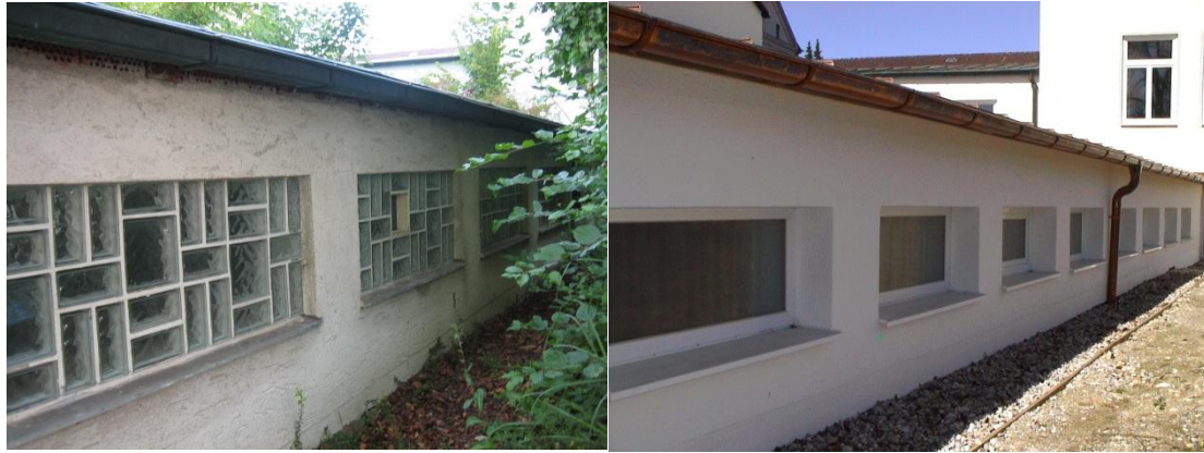
Abbildung 3-5: Ungedämmter Gang zum Hallenbad mit Glasbausteinen und nach der Sanierung
