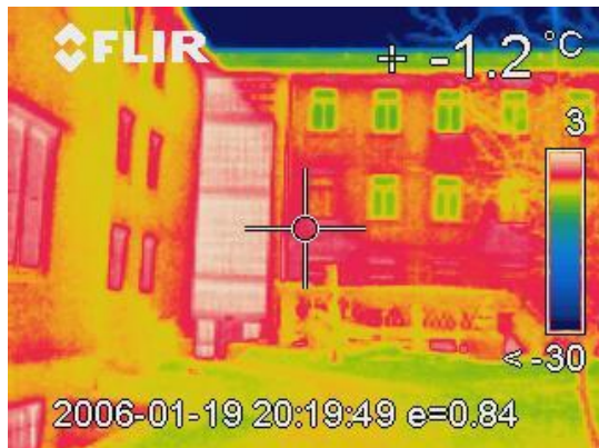
Abbildung 3-3: Nordfassade Gymnasium, altes Treppenhaus (mit Glasbausteinen)
