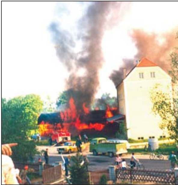
Die Klostermühle in Windach steht in Flammen
